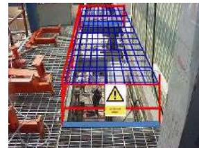
การปิดช่องเปิดเพื่อป้องกันการหล่นตก
